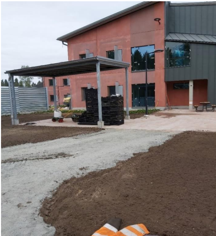
Kuva rakenteilla olevan Hämeenlinnan vankilan yhden osaston piha-alueelta.
